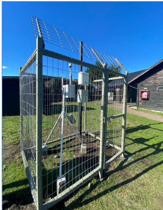
Imagen 2: Instalación y equipo en funcionamiento.
